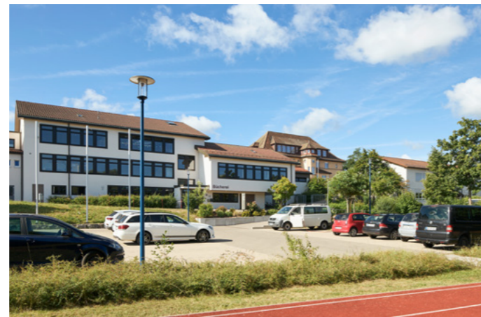
Der geplante E-Ladepark am Georg-Kropp-Areal
