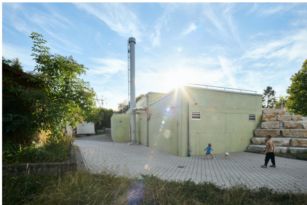
Wüstenrot hat zur Versorgung des Ortskerns ein Biomasse-Heizkraftwerk gebaut.
