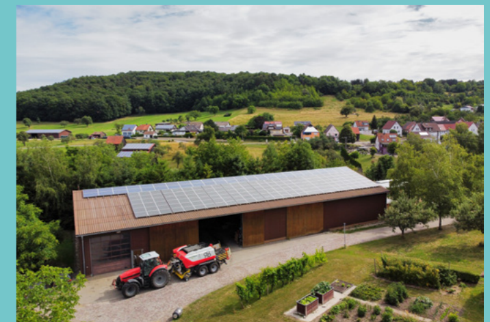
Sinns Scheune hat auf dem Dach eine große Photovoltaik-Anlage.
