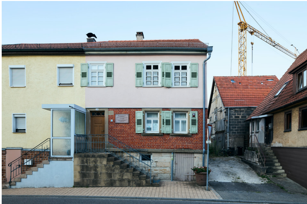
Das Bauspar-Museum im alten Ortskern von Wüstenrot
